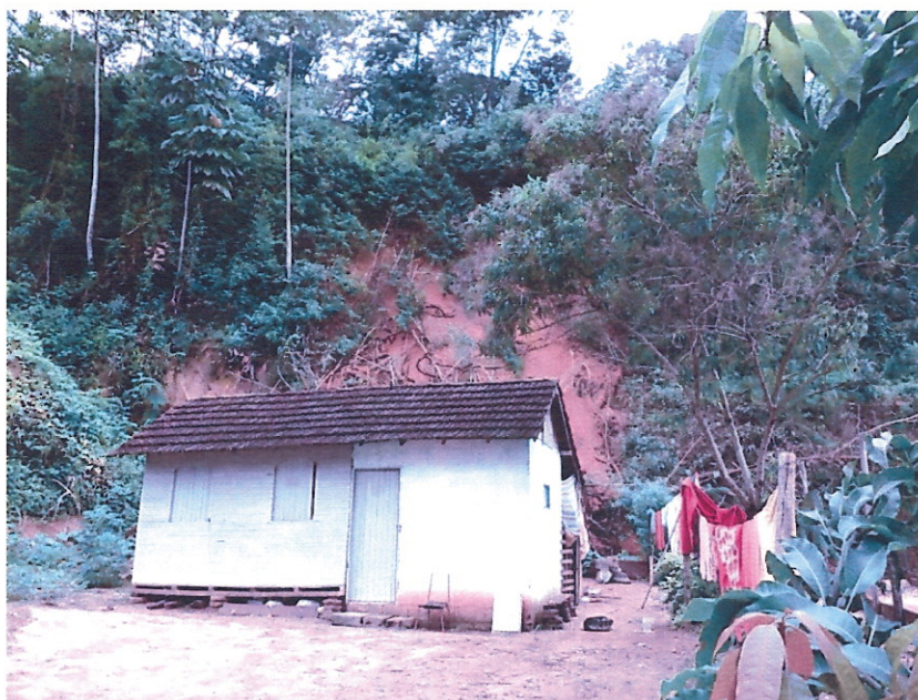
Barraco interditado - Queda de talude sobre barraco
