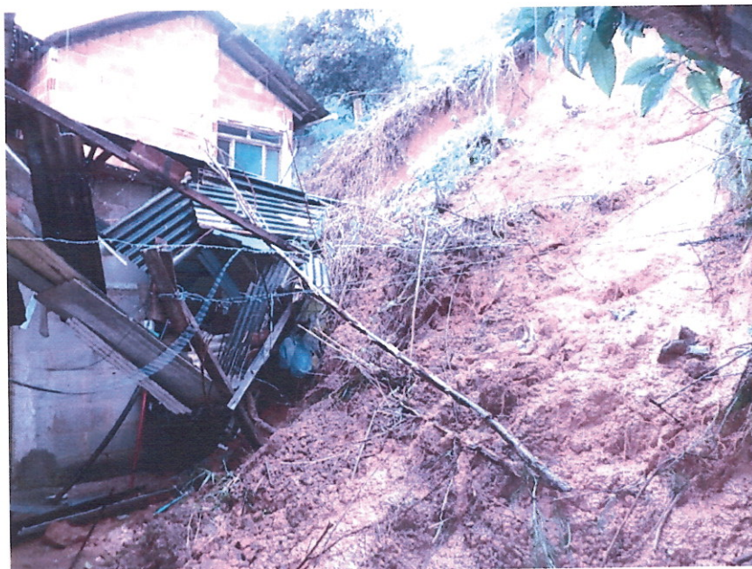
Casa interditada - Queda de talude sobre casa
