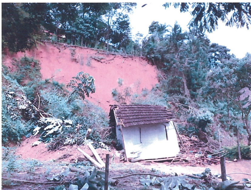
Barraco interditado - Queda de talude sobre barraco
