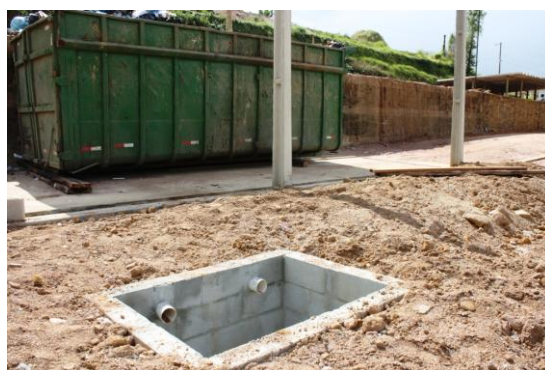
Figura 05 – Implantação de caixa coletora de chorume.
