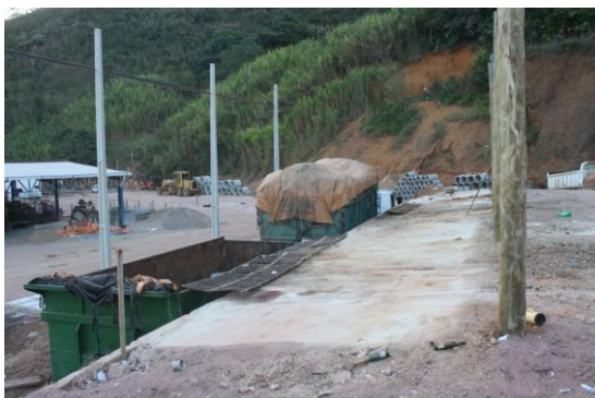
Figura 06 – Impermeabilização do pátio de descarregamento.
