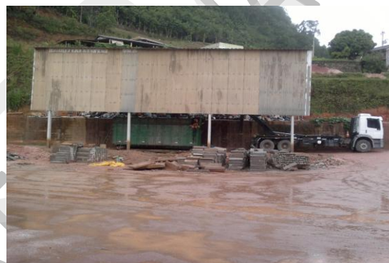
Figura 09 – Visão frontal da cobertura da Estação de Transbordo.
